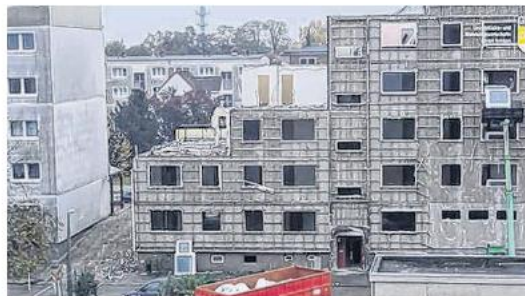
So soll der stufenweise Abriss später aussehen.
