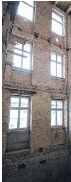
Noch ist das Gebäudeinnere komplett entkernt - samt Zwischendecken.
