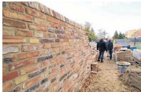
So sieht die Anklamer Stadtmauer nach der Sanierung aus.
