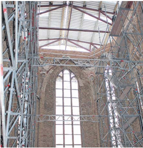
Im Inneren der Nikolaikirche macht sich Anfang 2010 ein Riesengerüst breit: Vorbereitungen für den Abbau des Notdaches und die Montage des neuen Daches.
