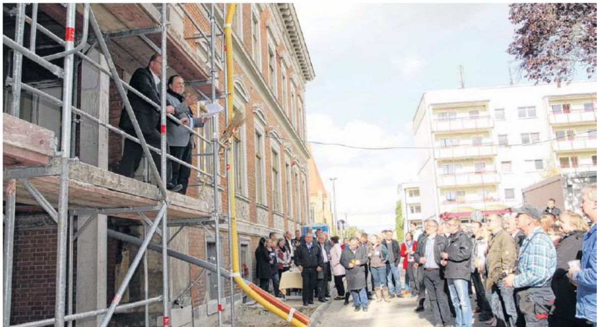
Richtfest an der „Alten Post“: Zum Gratulieren und Feiern waren neben Vertretern aus Politik und Wirtschaft vor allem auch die Bauarbeiter gekommen. Ende September 2018 sollen hier die ersten Gäste logieren.
