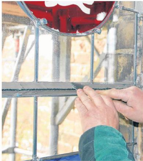
Mit Muschelkalk werden die Scheiben sorgfältig befestigt - Sturm und Regen können so den Wappenfenstern nichts mehr anhaben.
