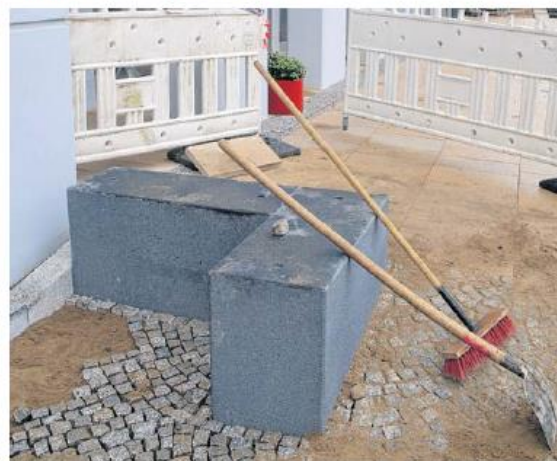
Auf dem Betonblock soll noch eine Sitzfläche aufgebracht werden.
