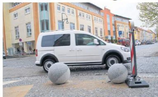
Die Granitkugeln an der Ecke zur Steinstraße liegen bereits, werden aber noch von Warnbarken flankiert.
