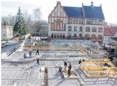
Die Kellerdecke ist bereits sichtbar. Zwei Stockwerke für den Technik- und Wellnessbereich inklusive Schwimmbad befinden sich darunter, drei kommen als Zimmertrakt obendrauf.
