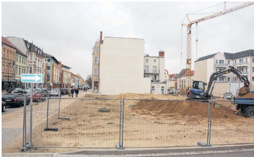
Begonnen wird die Bebauung an der Ecke zur Brüderstraße. Es ist Haus-Nummer 19. Rund 3,4 Millionen Euro wird das Vorhaben kosten.
