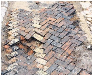
Die historischen Klosterformatsteine des Kellerfußbodens sind noch sehr gut erhalten.
