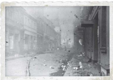
Das historische Gebäude in der Keilstraße wurde nach einem Bombenangriff 1943 durch einen Brand in Schutt und Asche gelegt. FOTO: STEINTOR-MUSEUM
