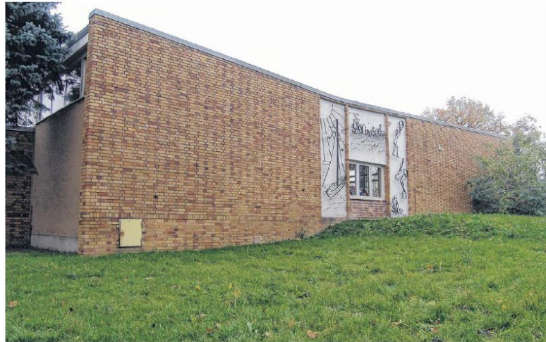
Die Schwimmhalle wurde 1968 gebaut und steht unter Denkmalschutz. Eine Sanierung ist dringend notwendig, im Herbst könnte es losgehen.
