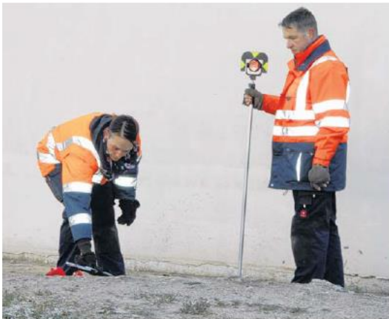
Bevor die Pfähle gesetzt werden können, muss jede einzelne Position genau vermessen werden.
