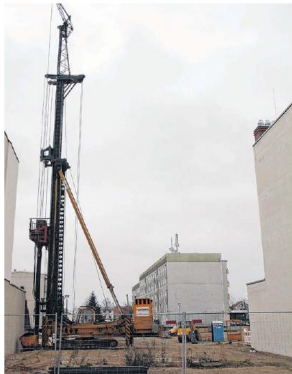
Insgesamt 26 Pfähle werden in das Erdreich getrieben, die dann mit Stahlbeton gefüllt werden.
