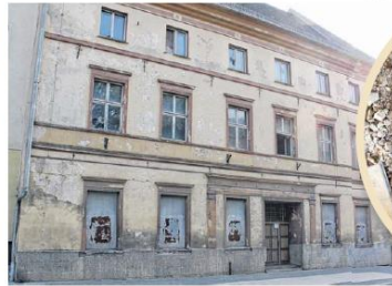
Im nächsten Jahr sollen die Arbeiten an der Fassade beginnen.
